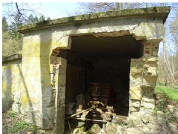
Obr. 12: Stará vodárna pro osadu Proseč
