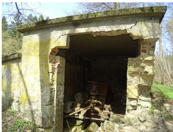
Obr. 12: Stará vodárna pro osadu Proseč
